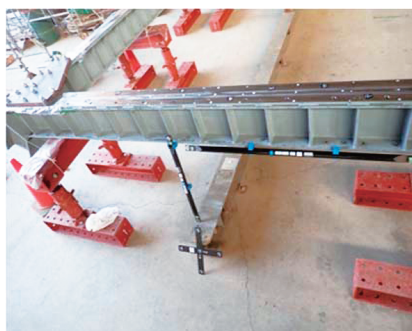
写真7 検査計測ターゲット状況
