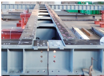
写真1 BH材前面加工状況
