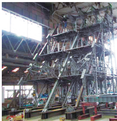
写真4 仮組立状況(正面)
