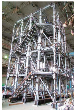
写真3 仮組立状況(背面)
